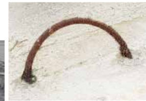
Lastverteilung durch Beton mit Transportösen
