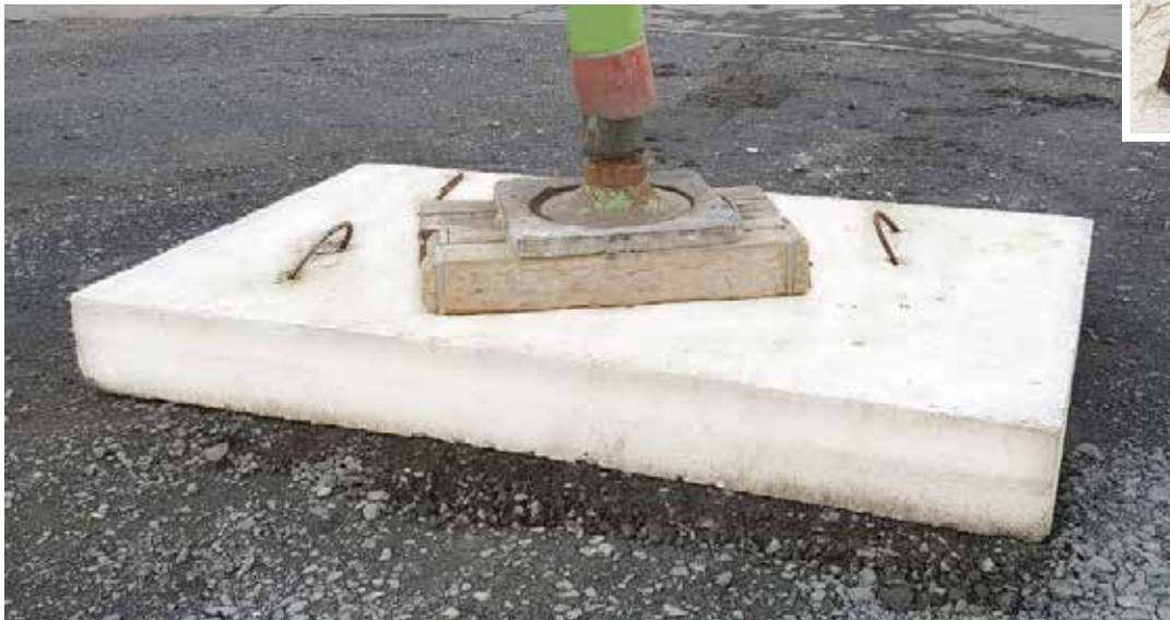
Lastverteilung durch Beton mit Transportösen
